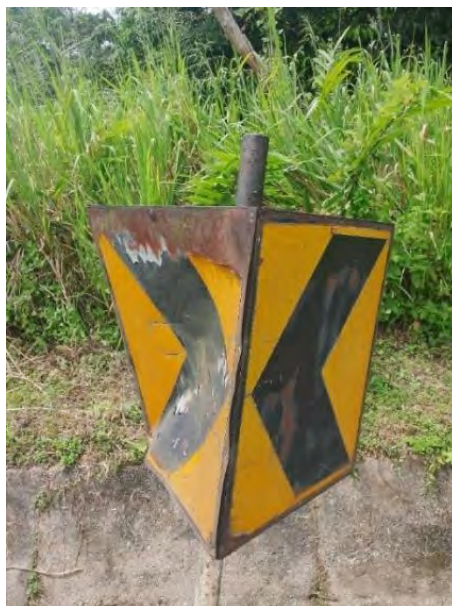
Gambar Rajah 9. Papan Tanda Chevron yang Rosak
