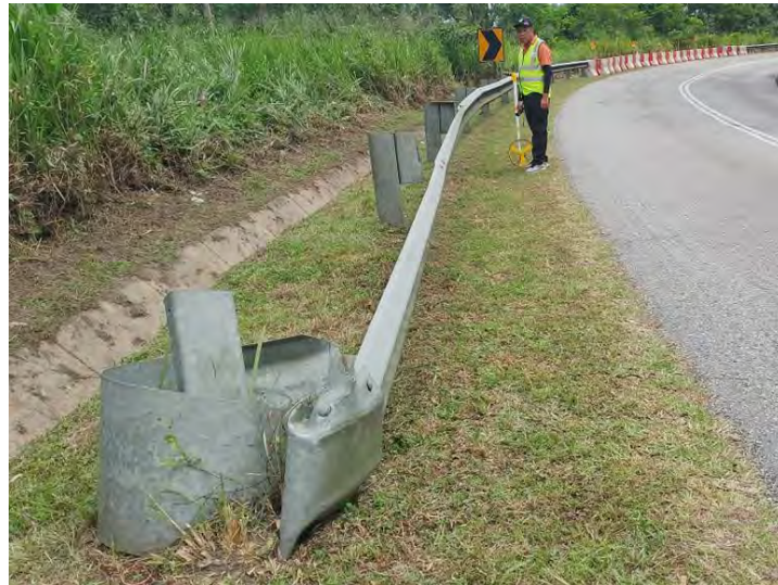
Gambar Rajah 8. Keadaan Hujung Penghadang Jalan (Terminal)
